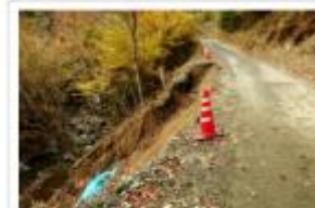
西日本豪雨から4カ月たっても路肩が崩れたままの市道。冬場に除雪車が通るのは危険だという＝宍粟市一宮町河原田
