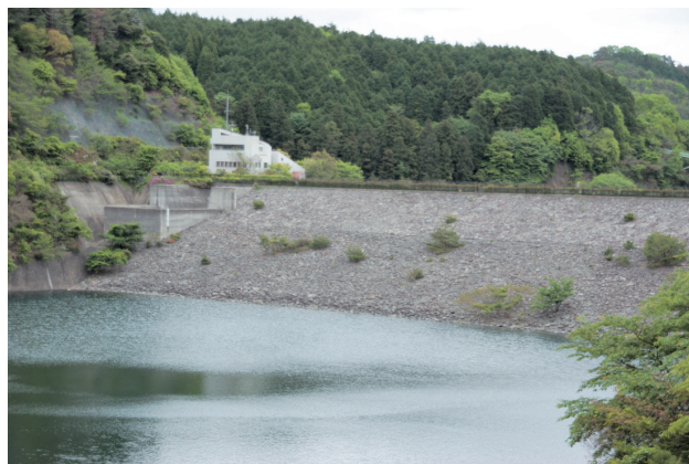
図17-3：箕面川ダムの堤体。表面がゴツゴツしているのは、超丹波帯の砂岩を積み上げているため。
