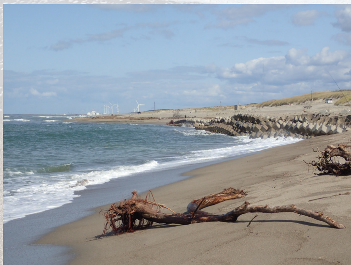
図 22：海岸侵食の進む砂浜。砂浜の一部が侵食され、消波ブロックが露わになっている。山形県酒田市庄内海岸(26ページ⑦)。
