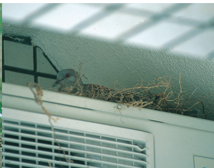
建物につくられたキジバトの巣
